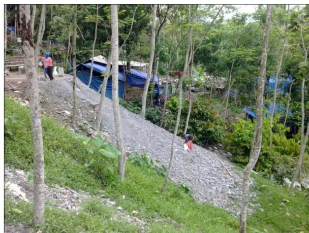
Gambar 6. Batuan sampling yang ditimbun dipinggir lereng, memungkinkan terjadinya longsoran
