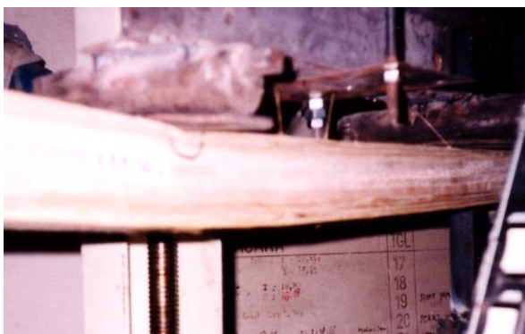
c) Kerusakan balok RBB.50
