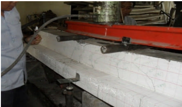
Gambar 12 Pola retak balok perkuatan tipe 2 (BP2).
