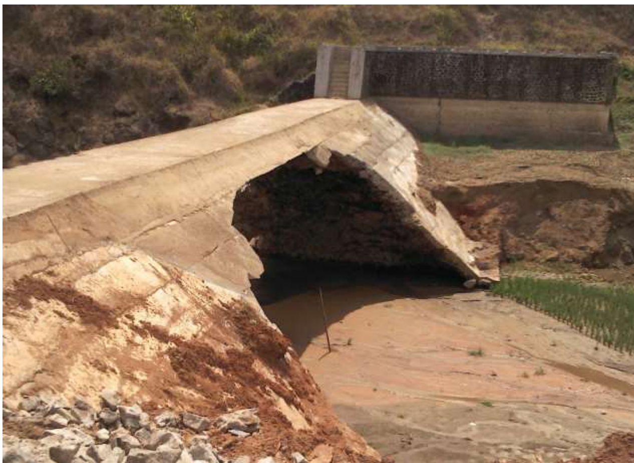
Gambar-5. Sisi hulu spillway pada BPS Kedung Ringin.
