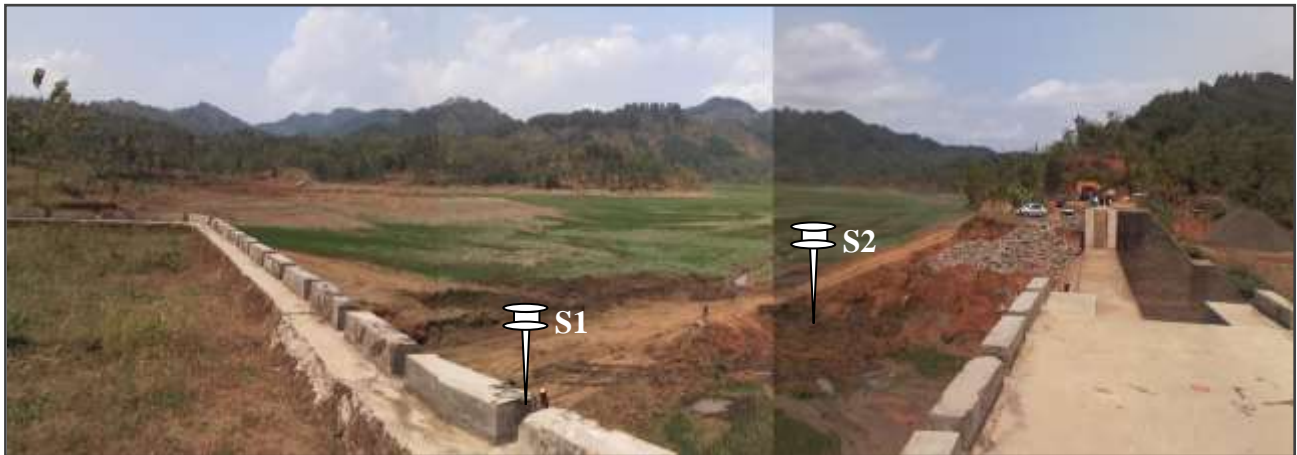
Gambar-1. Daerah hulu (tampungan air) pada BPS Kedung Ringin.
