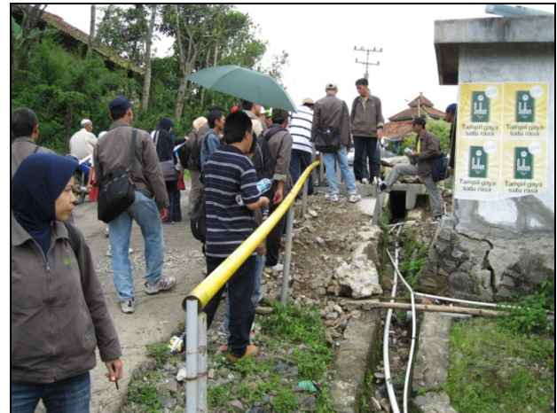
Gambar 7 Kondisi drainase Desa Kalitlaga.
